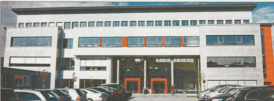
Das neue Hörsaalgebäude der Hochschule Fresenius in Idstein wurde gestern eingeweiht. Zugleich feierte man auch das 160-jährige Bestehen des Chemischen Laboratoriums Fresenius.
