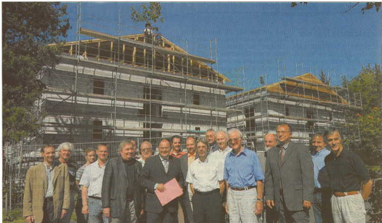
Im Frühjahr 2005 sollen 20 geistig behinderte Menschen im neuen „Alten Haus“ des Kalmenhofs einziehen. Foto: wita/Udo Mallmann
